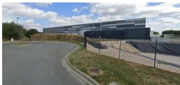
Photo 4 : Vue à l'Ouest
