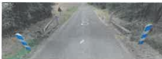
Vue sur le fossé du cours d'eau situé le long de la D121 Source : Google Street View, 2022
