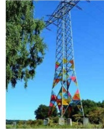
Pylone 225kV habillé - en option
