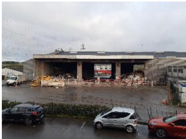
Bâtiment CSR (Façade Sud)
