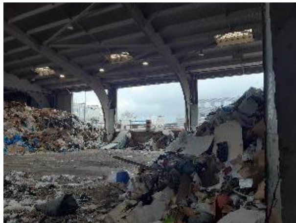
Bâtiment CSR (intérieur)
