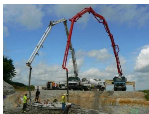
Figure 145 : Exemples de ferrailage et coulage des fondations
