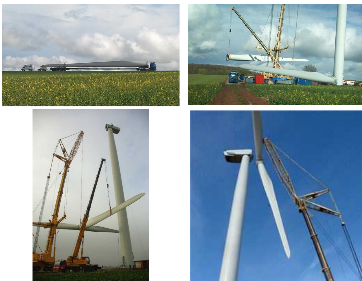
Figure 146 : Exemple de séquences d'assemblage d'une éolienne
