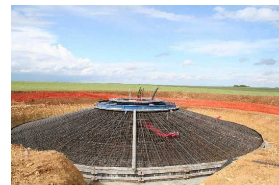
Figure 145 : Exemples de ferrailage et coulage des fondations
