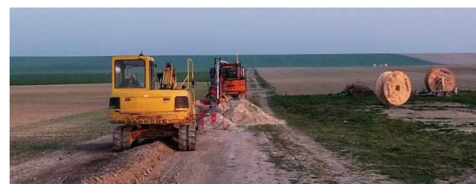
Figure 147 : Exemple de travaux pour l'installation du raccordement enterré
