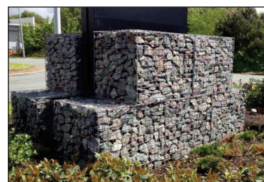
Figure 23 : Exemple de muret en gabion (Source : TCS Geotechnics)
