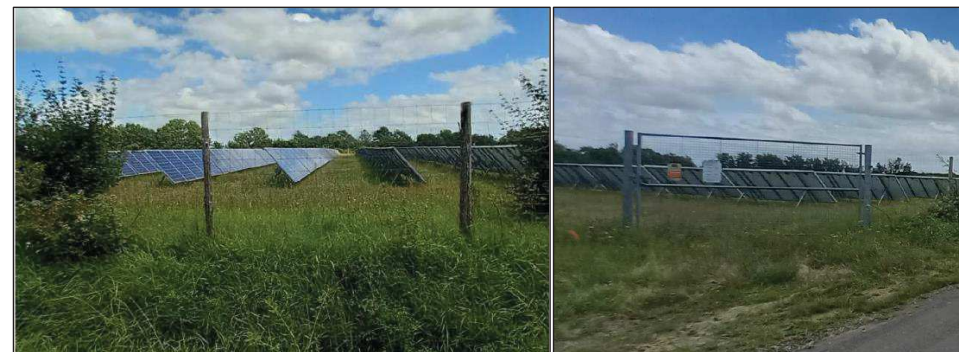
Figure 35 : Exemple de grillage et portail d'accès
