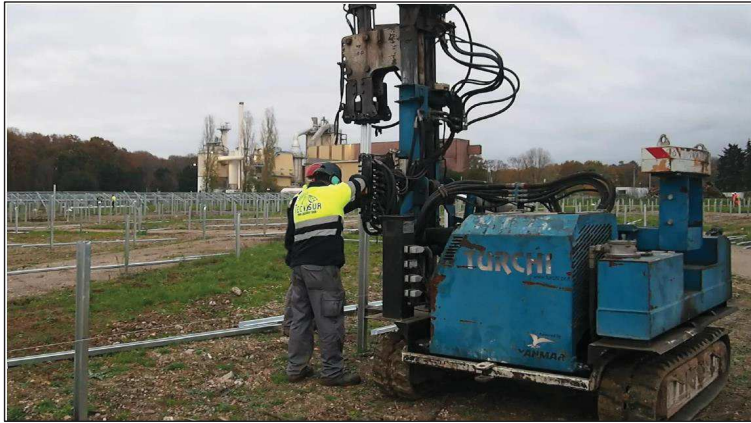
Figure 24 : Battage de pieux (Source : SOG SOLAR)
