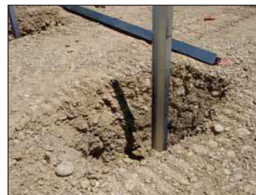
Figure 21 : Types de fondation - pieux battus (Source : Guide MEDDTL 2011 – NCA, 2015)
