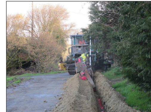
Figure 33 : Trancheuse pour enfouissement des câbles HTA
