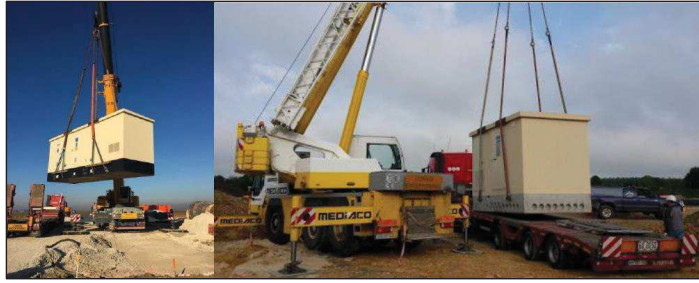
Figure 30 : Grutage d'un poste de livraison et d'un poste de transformation
